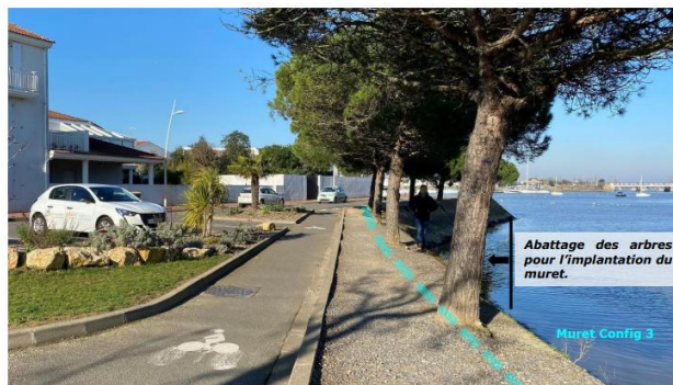
Figure 33 - Localisation du muret
