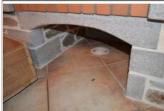
Prise d'air de l'insert sous l'insert prenant
