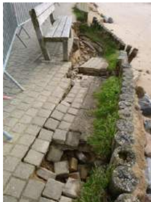
Dégradations sur l'ouvrage après tempête - Marais Girard
