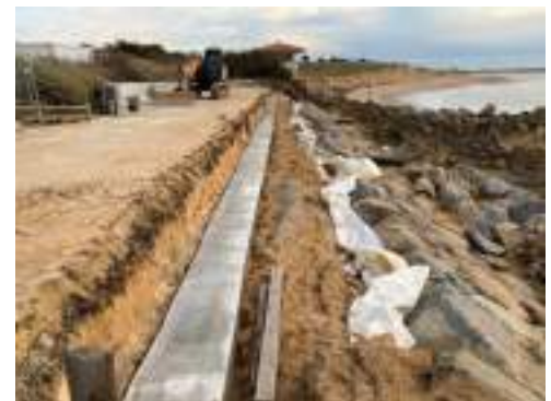
Pose du mur préfabriqué en béton
