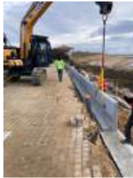
Pose du mur préfabriqué en béton
