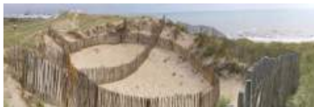
Renforcement d'un brise-vent
