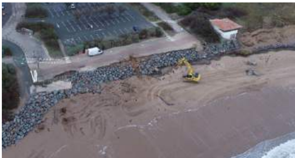
Novembre 2023 : début des travaux – Marais Girard, à Brétignolles sur Mer
