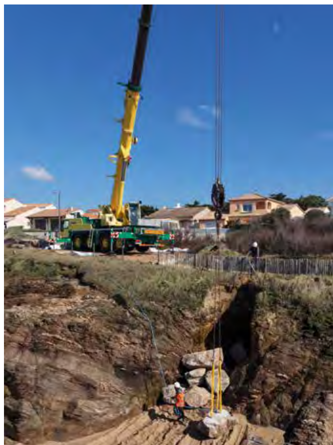
Photo 27 : Pose de blocs rocheux et comblement de la cavité
