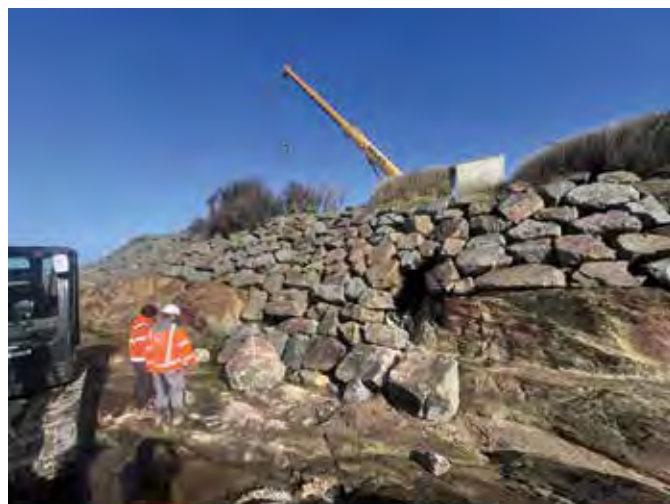
Photo 21_B : Travaux d'entretien de l'ouvrage BRET_0013, Brétignolles sur Mer
