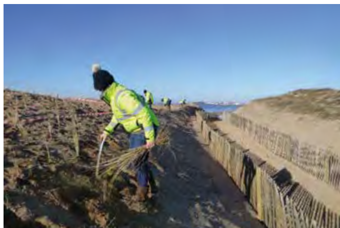
Techniciens du service Littoral et gestion des risques – plantation d'oyats à la plage de Kerlo, Saint Gilles Croix de Vie © Pays de Saint Gilles Croix de Vie Agglomération
