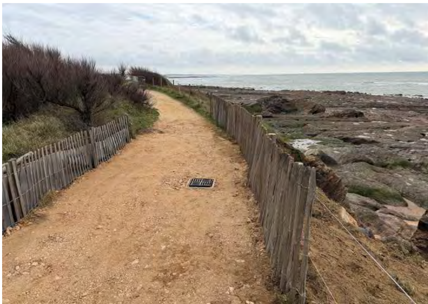
Photo 28 : Réfection du sentier et pose de canalisation pour faciliter l'écoulement des eaux pluviales
