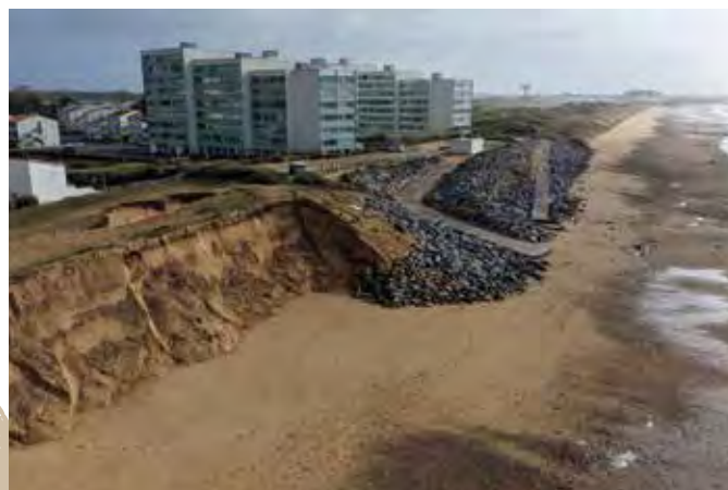
Vue drone Saint Hilaire de Riez - janvier 2026 © Pays de Saint Gilles Croix de Vie Agglomération
