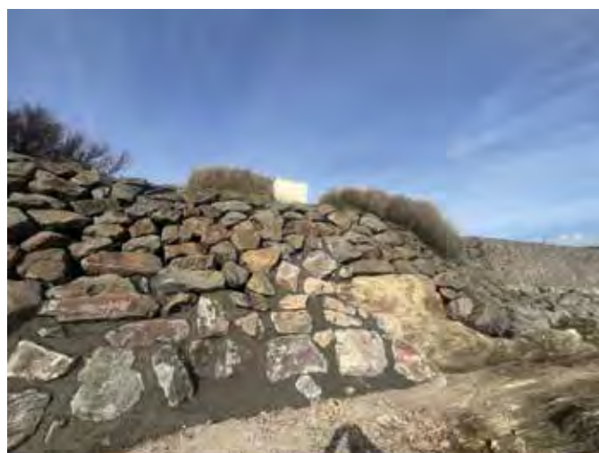
Photo 22 : Bétonnage du pied de l'ouvrage BRET_0013, Brétignolles sur Mer
