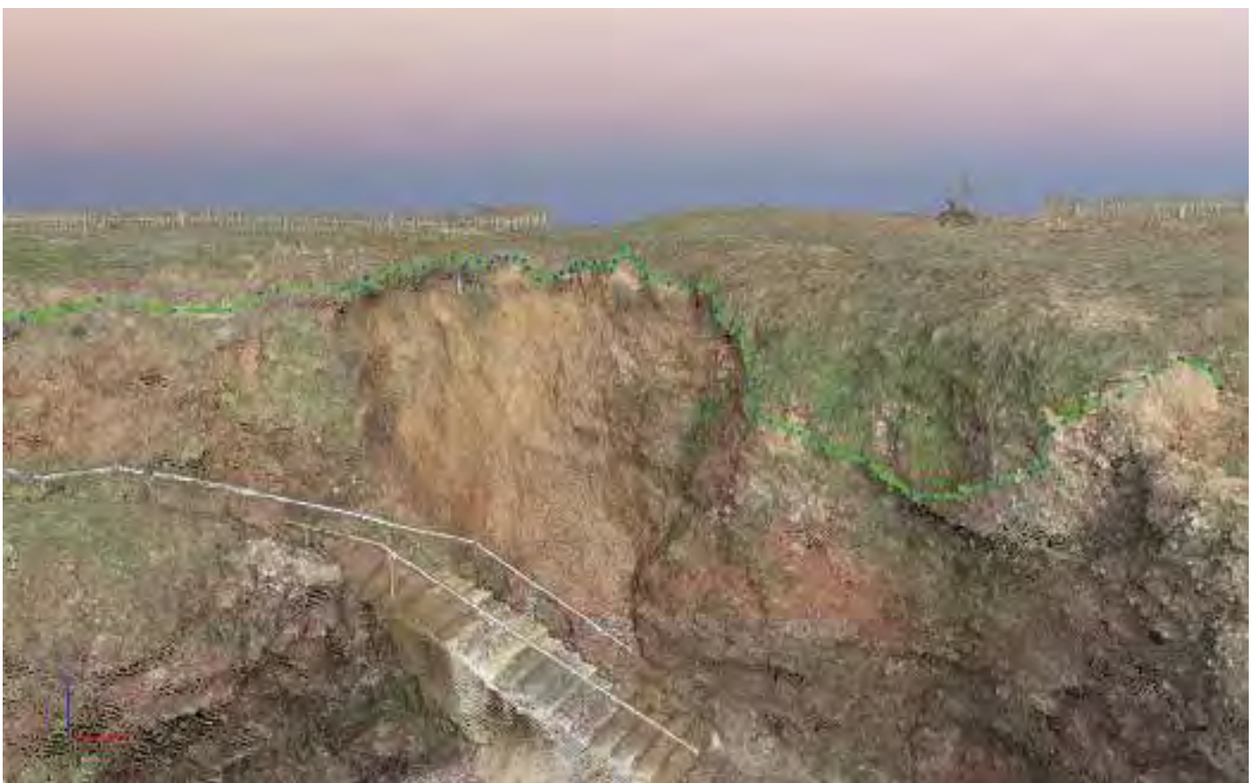
Photo 24 : Numérisation de la crête de corniche via le logiciel Pix4D survey
