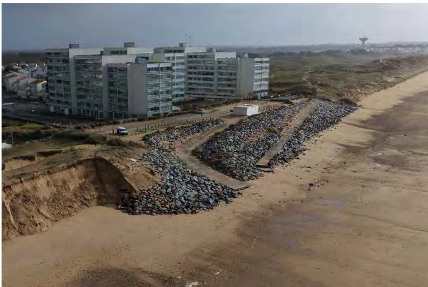
Photo 16 : Encoche d'érosion post-tempête février 2026 sur le site des Becs, Saint Hilaire de Riez © Pays de Saint Gilles Croix de Vie Agglomération
