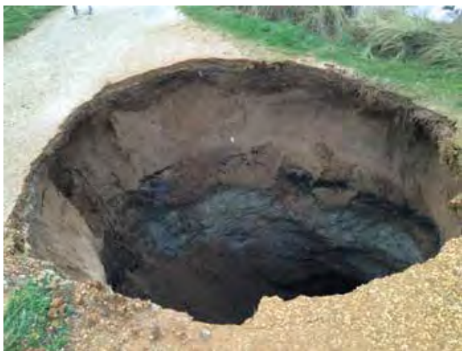
Photo 23 : Effondrement de la corniche, Brétignolles sur Mer novembre 2017
